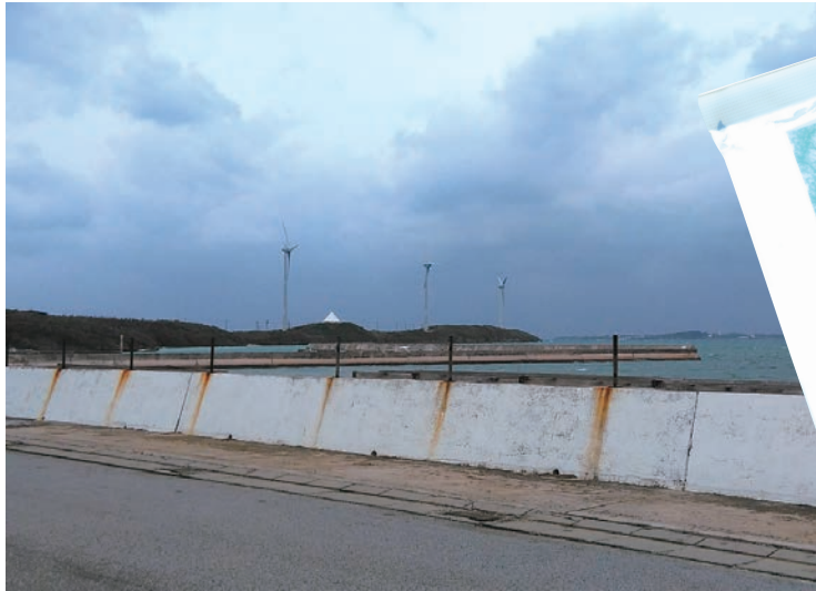
雪塩ミュージアム前の海岸には3基の風力発電風車が稼働していた。 とにかく、宮古島はつねに強風が吹いているように思えた。
